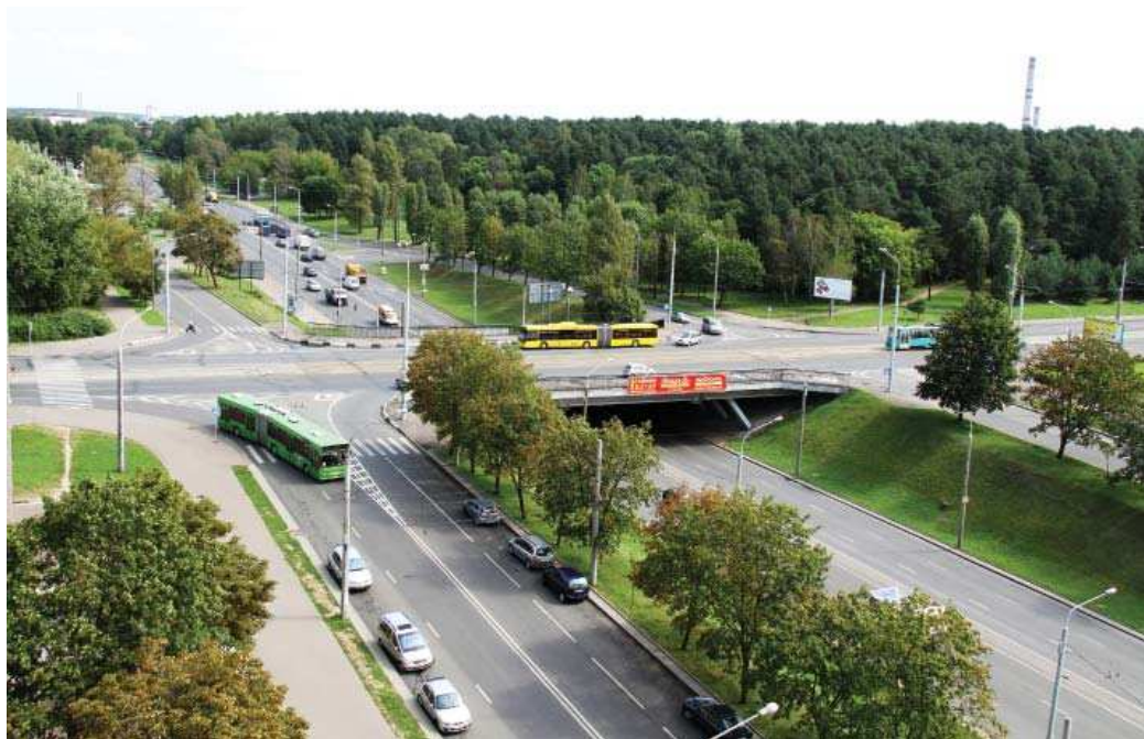
Путепровод на пересечении улиц Козлова и Ванеева
