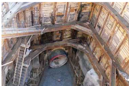
Строительство дождевого коллектора «Центр»
