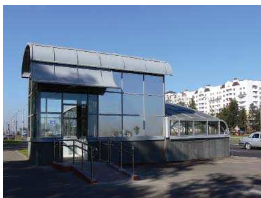
Подземные переходы в промрайоне «Шабаны»
