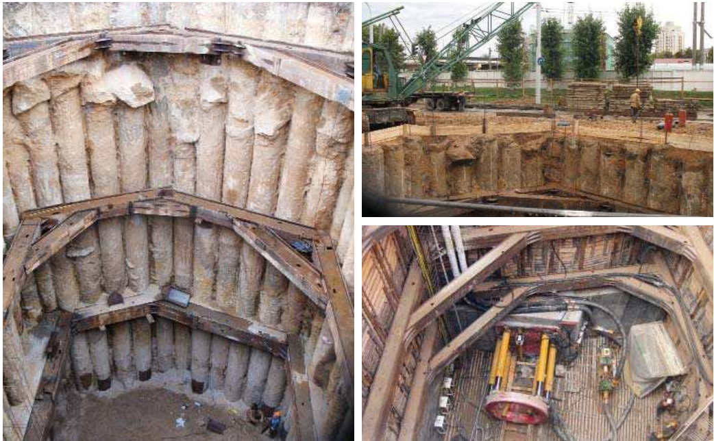
Строительство дождевого коллектора «Немига»
