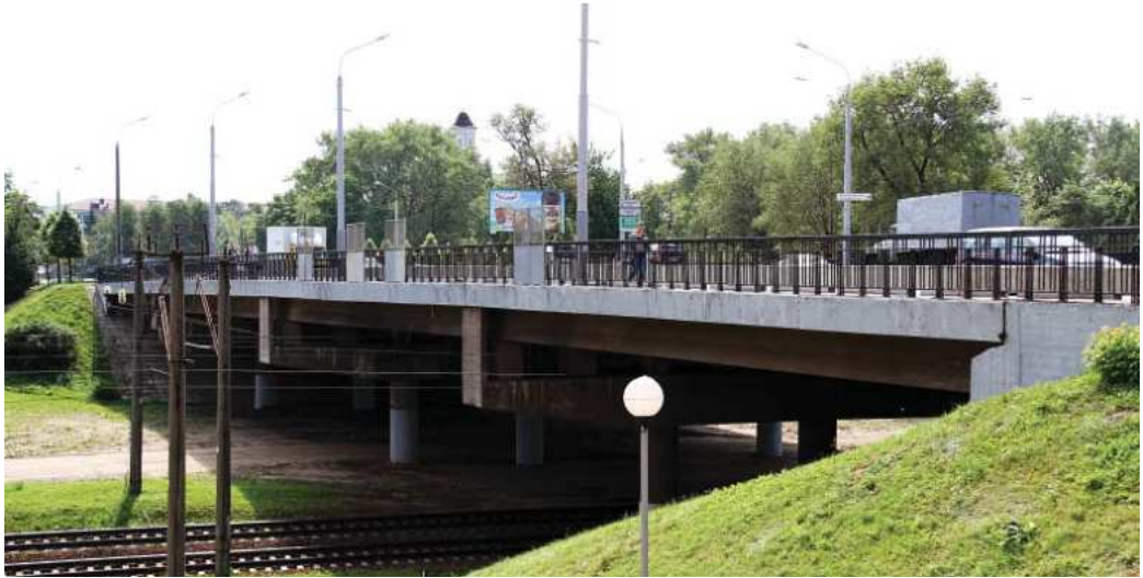
Путепровод в районе тракторного завода
