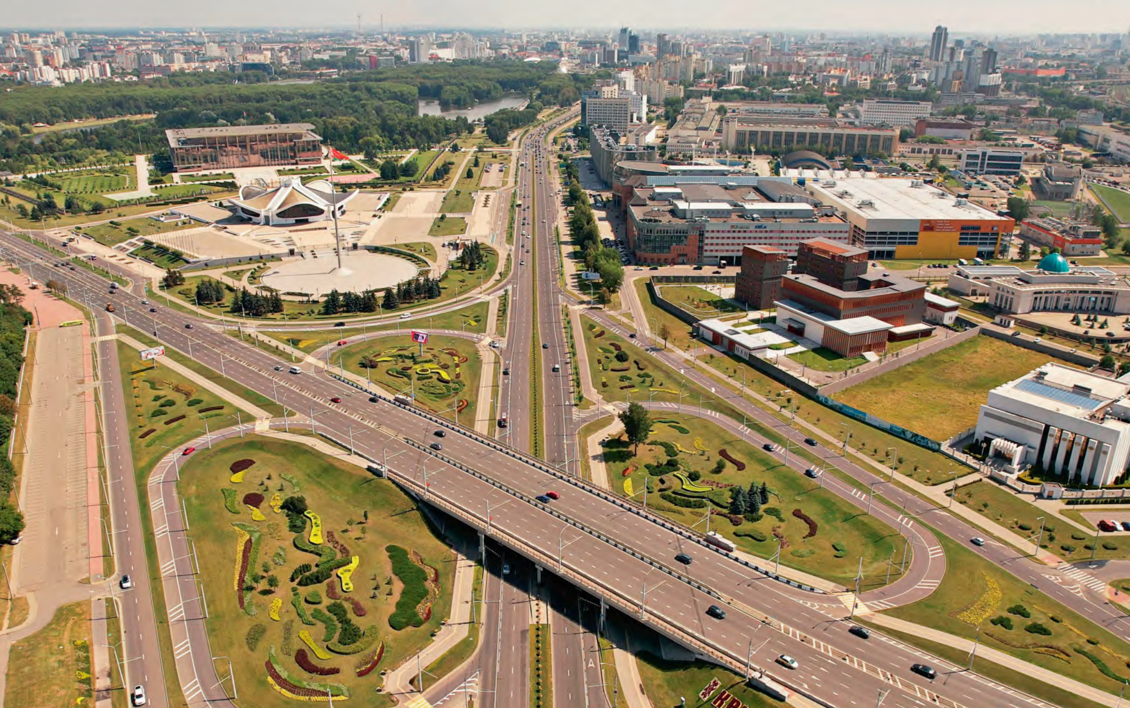
Реконструкция путепровода через просп. Победителей по ул. Орловской в г. Минске, 2020г.
