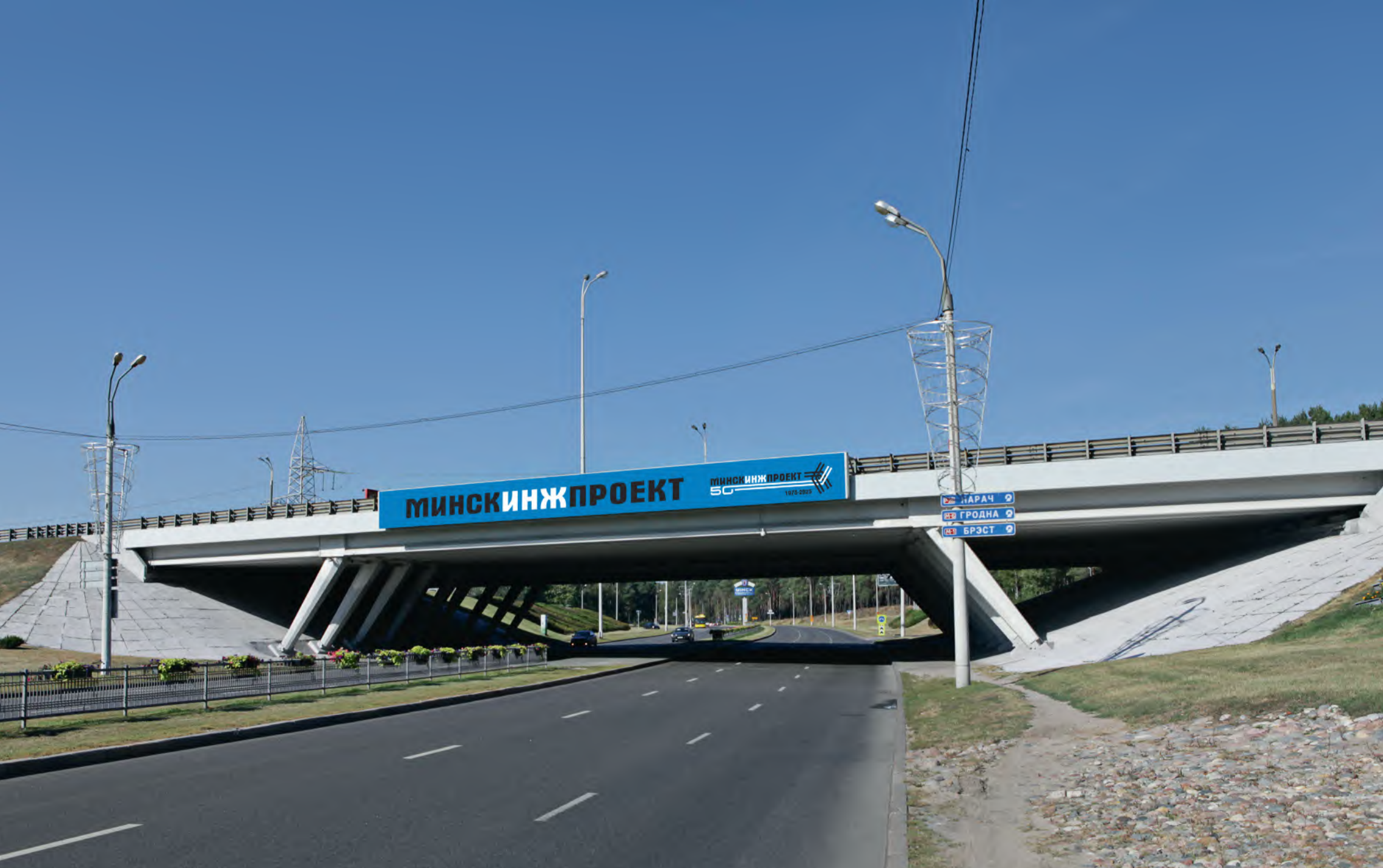
Путепровод на пересечении пр. Победителей - МКАД
