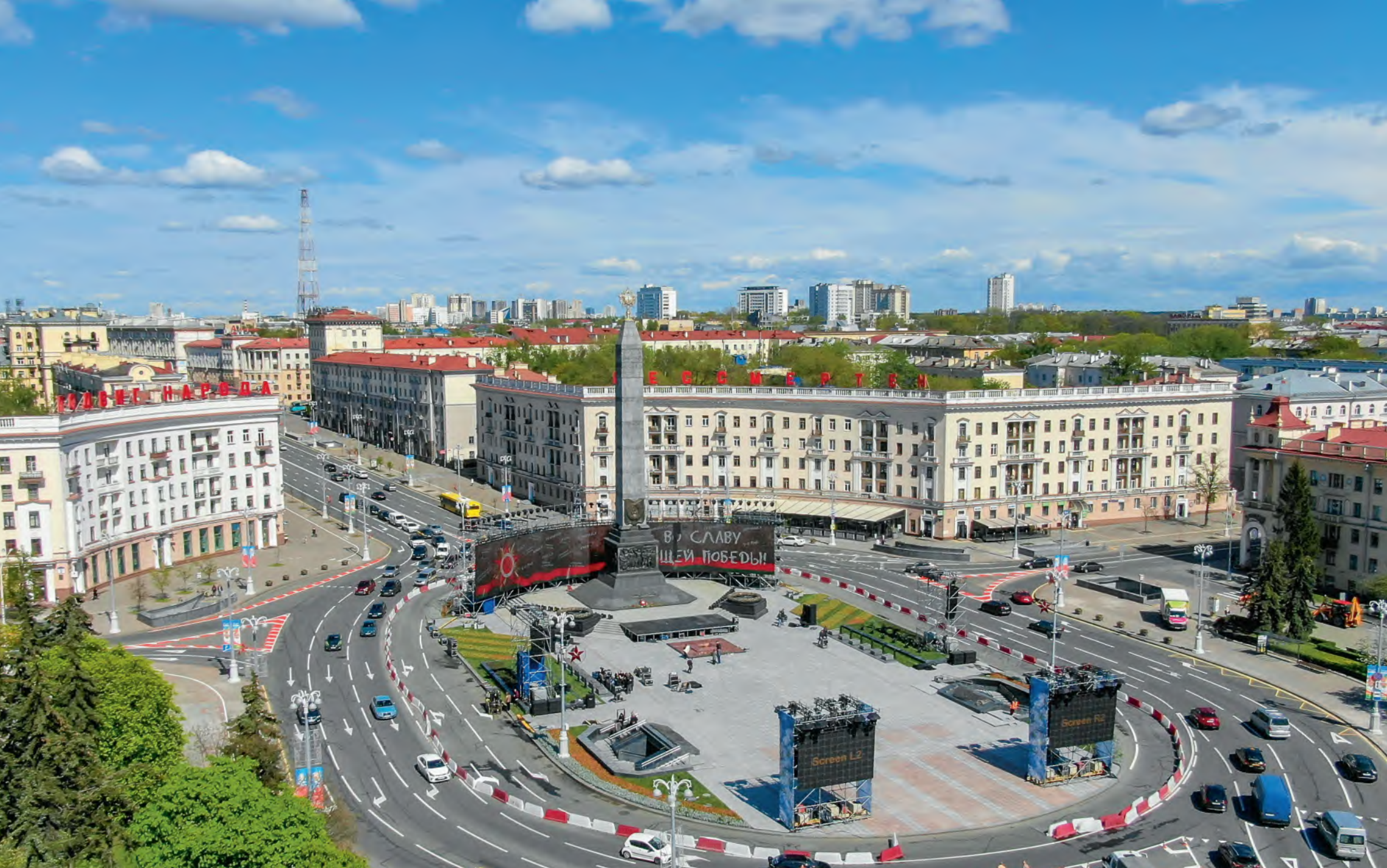
Капитальный ремонт с модернизацией площади Победы
